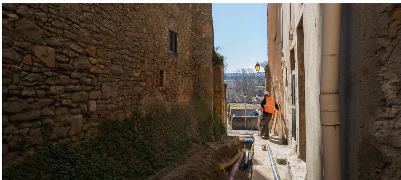
L'Agglo réalise des travaux sur les canalisations et réseaux d'eau potable et assainissement.
